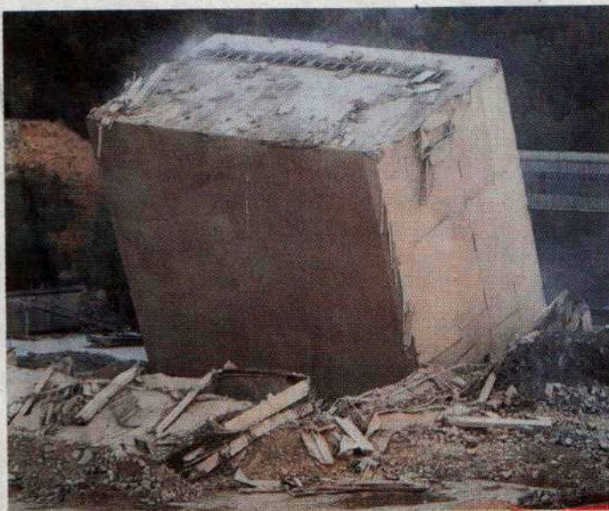
Für Statiker Anlass zur Freude, für Stefan Raab ein Grund zum Spott ist das Gebäude im Weisnauer Steinbruch nach der nicht ganz geglückten Sprengung.
